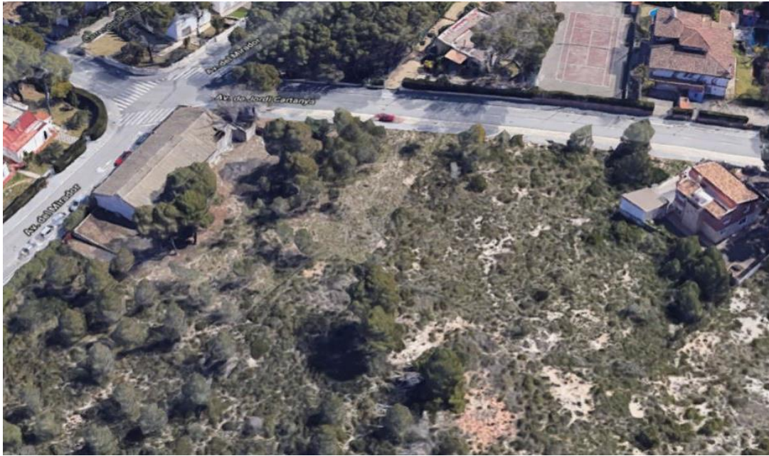
VISTA GENERAL DE L'ÀMBIT
